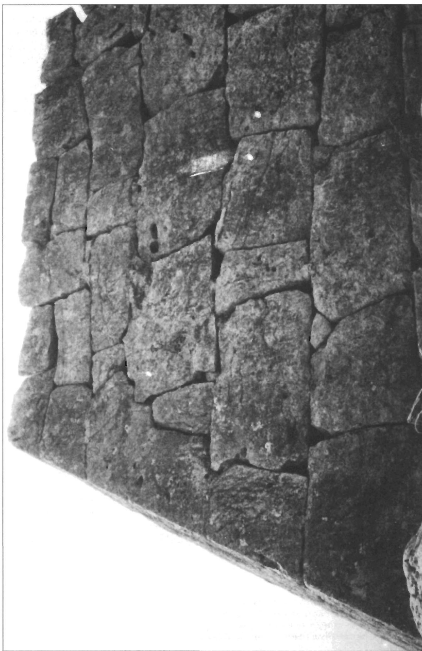
Βόρειος πλευρά, ανατολική γωνία της πυραμίδος του Ἑλληνικοῦ. Λεπτομέρεια τῆς θανμάσιας τοποθετήσεως καὶ συναρμογῆς τῶν λίθων.
