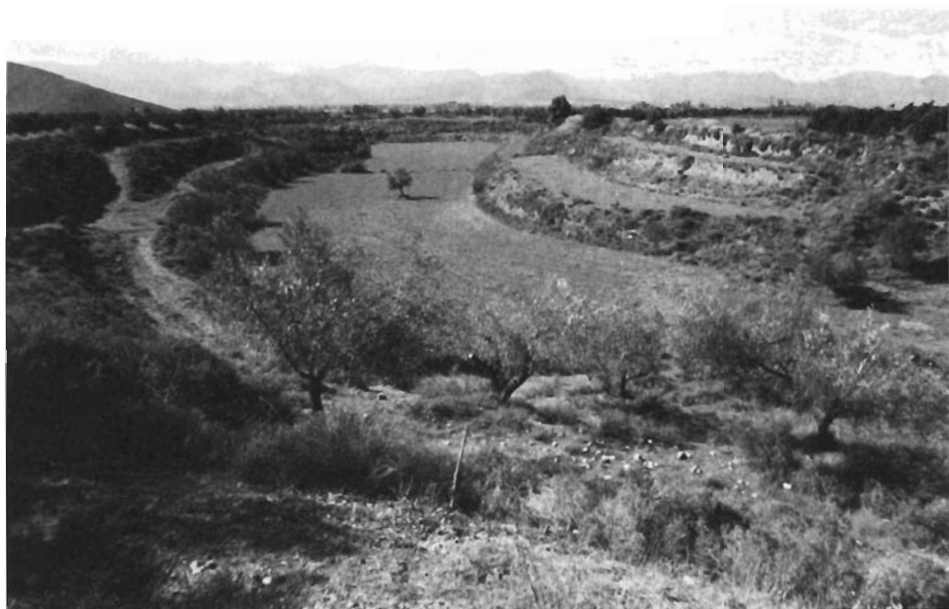
Τὸ μυκηναϊκὸ φράγμα, φωτογραφούμενο ἀπὸ τὴν κορυφὴν του με ἄποψη τῆς κοίτης τοῦ ἐκτραπέντος ἤδη ἀπὸ τὴν μυκηναϊκὴ ἐποχὴ ποταμοῦ. Ἐκτροπὴ πού προ-στατεύει ἀκόμη καὶ σήμερα τὴν κωμόπολη τῆς Τίρυνθας ἀπὸ τὶς πλημμύρες!
