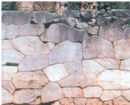
Φωτ. 8. Τμήμα τοῦ πολυγωνικοῦ τοίχου.
