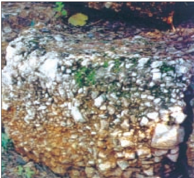
Φωτ. 6. Λιθόδεμα (μπετόν) τείχους (Πλατεία Κλαυθμώνος).
