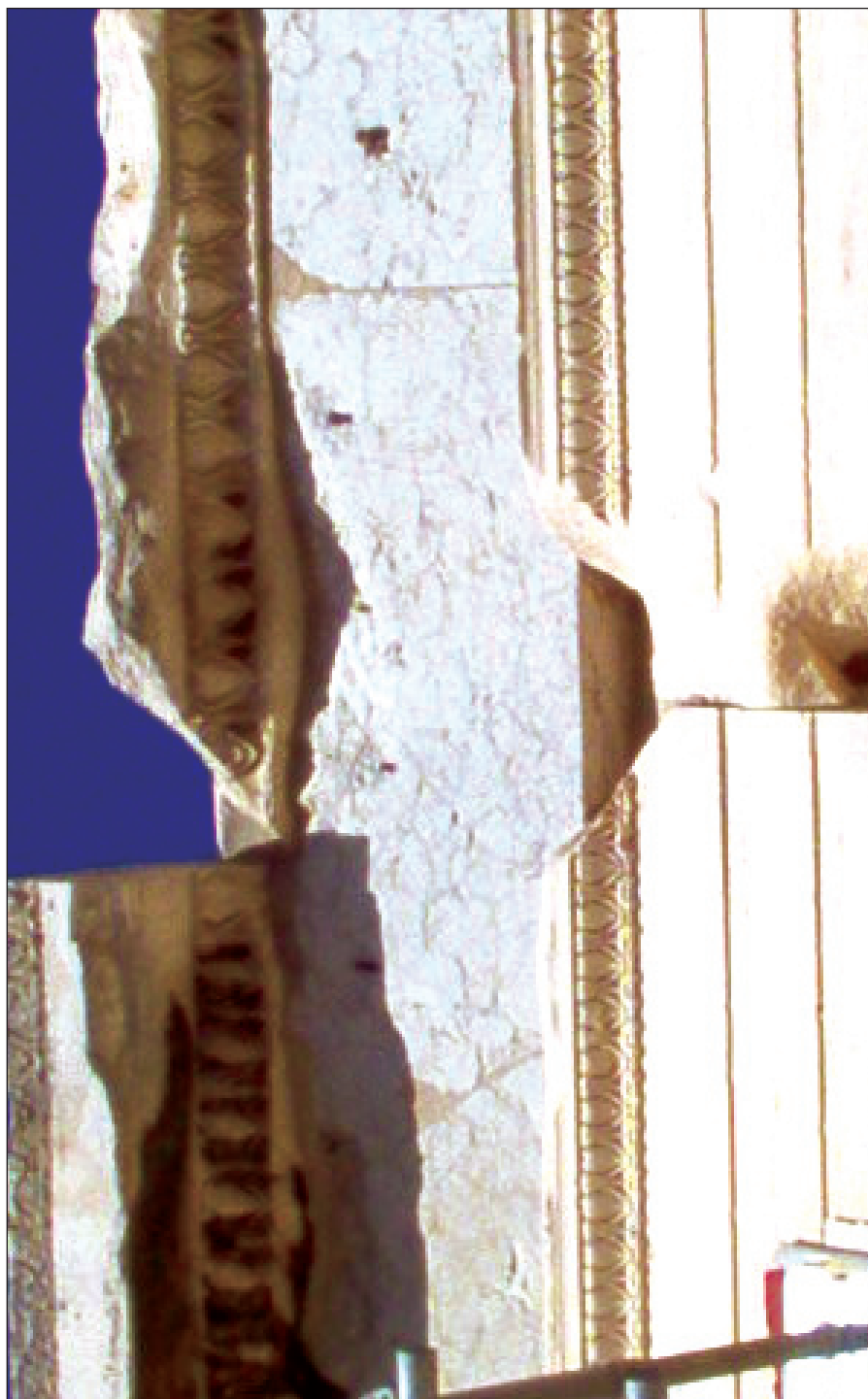
Τοιμεντένα τμήματα ποὺ προστέθηκαν στὸν Παρθενῶνα κατὰ τὴν προηγουμένη «ἀναστυλῶση»: δὲν διέφερε πολὺ ἀπὸ... βανδαλισμό.
