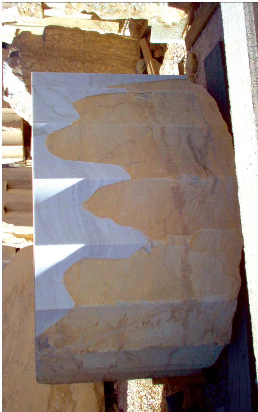
Σπόνδυλος με τις νέες προσθήκες από μάρμαρο Πεντέλης. Προφανής η διαφορά λευκότητας άλλα και αισθητικής.
