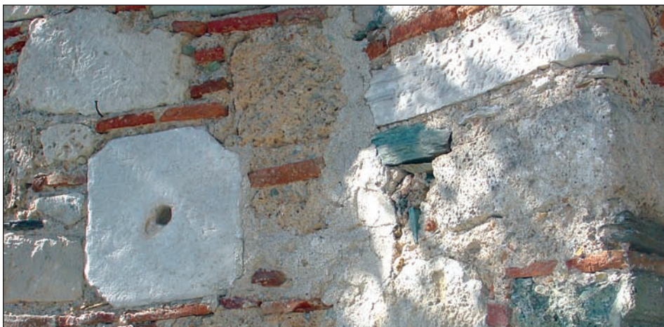
Ἡ τοιχοδομία τοῦ ναοῦ Μεταμορφώσεως Βόλου. Βρίσκεται στὸ λόφο Ἐπισκοπῆς, ὅπου ἔχουν κτισθῇ τέσσερις ἀκόμη βυζαντινοὶ ναοί, ὅλοι μὲ ἐνσωματωμένα ἀρχαῖα ἀρχιτεκτονικὰ μέλη.
