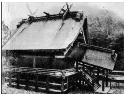
Φωτ. 13. Ναὸς Sindo: Τὸ ὄραϊον.
