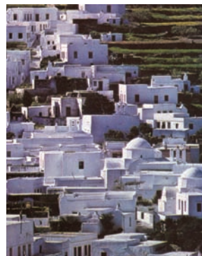
Φωτ. 7. Αναβαθμοί στη Σίφνο.
