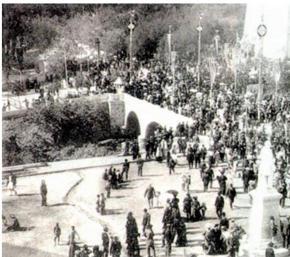
Ἡ τρίτοξη γέφυρα Ἰλισσοῦ (Φωτ. τοῦ 1896, «Ἐλευθεροτυπία», Ἱστορικά, τ. Β', τ. 58).
